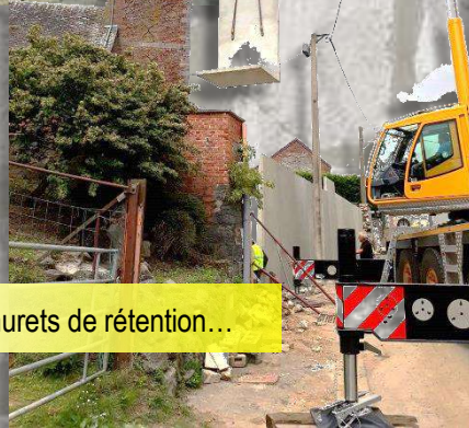
Le placement des couvre-murs et remblaiement...
